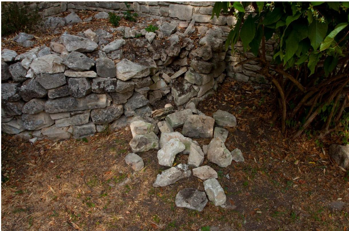
De nouveaux désordres sont survenus dans le jardin de la Quincaillerie à Barjac : un des petits murets circulaires montés en pierres sèches s'est écroulé. Ce muret retenait des blocs de pierres entassés en vrac.
